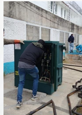
Evidencias de los trabajos de engrasado de bombas, cambio de aceite a los tranformadores, cambio de interruptores de tableros, entre otros.
